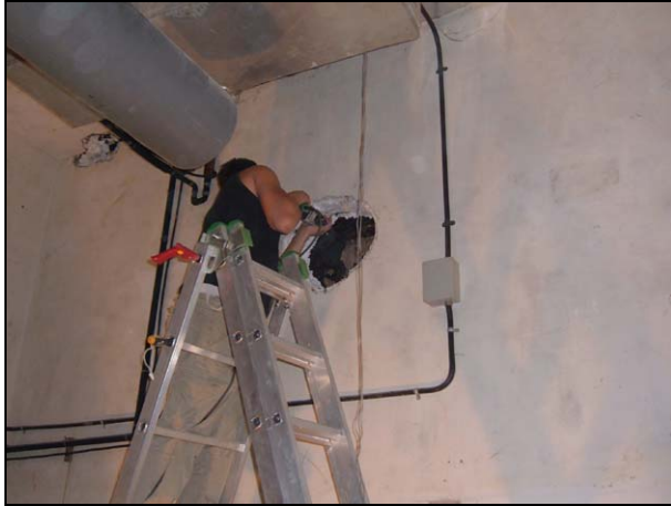
FOTO 1. Realització de la perforació a la paret del soterrani
