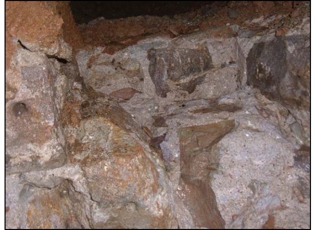
FOTO 6. Vista detall del mur UE 7
