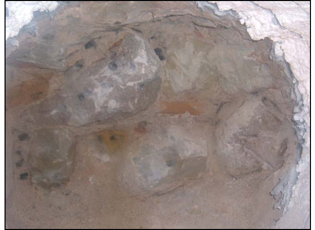
FOTO 2. Estat final de la perforació realitzada a la paret del soterrani
