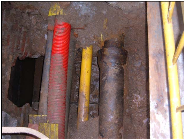
FOTO 7. Vista general del mur UE 7 sota els diferents serveis i cobert parcialment per la UE 8
