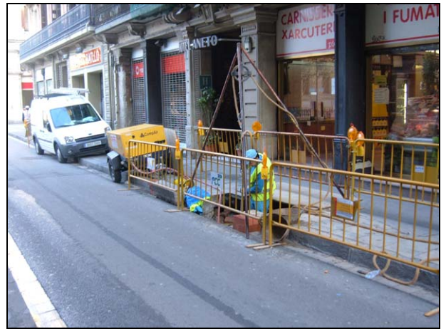
FOTO 4. Excavació de la Rasa 1
